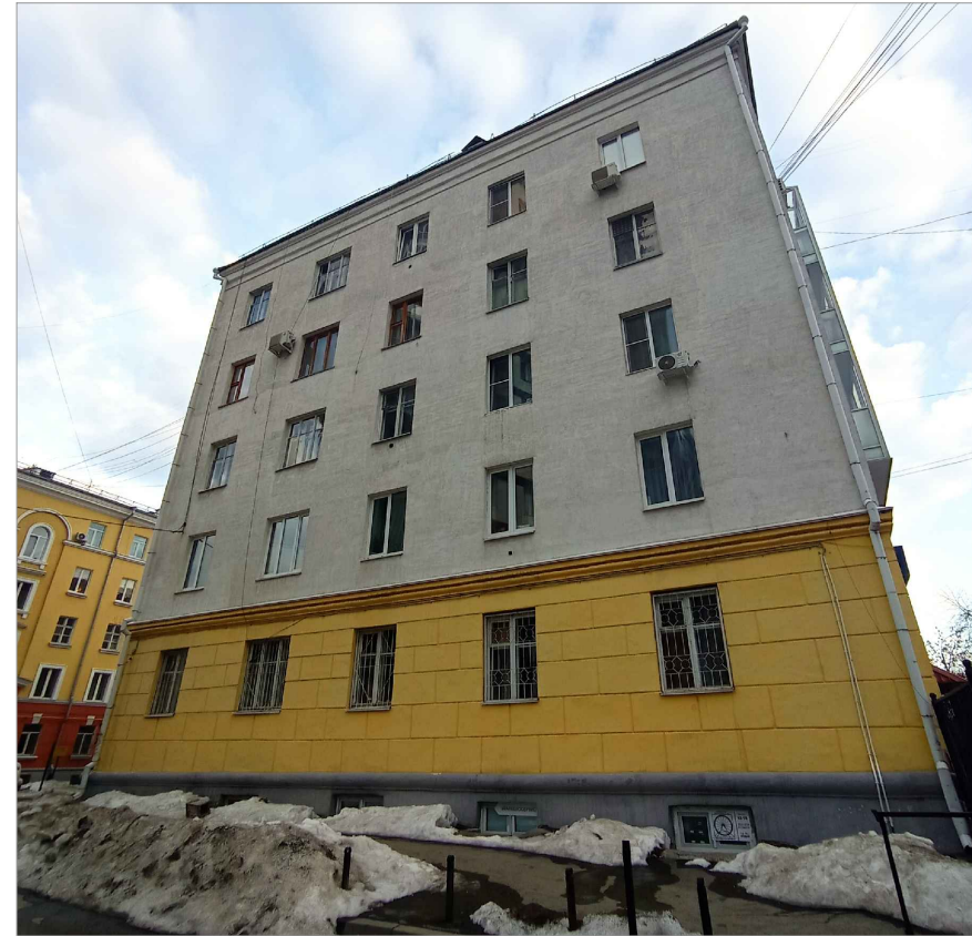
Фасад торцевой по ул. Белинского
